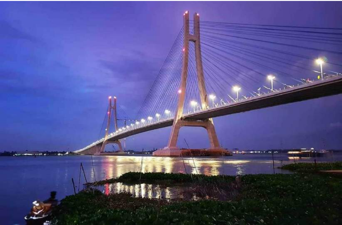
CẦU VÀM CỐNG VAM CONG BRIDGE
